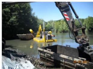
Opérations de curage par barge équipée d'une benne preneuse, **chargement** des chalands et **rotation**
